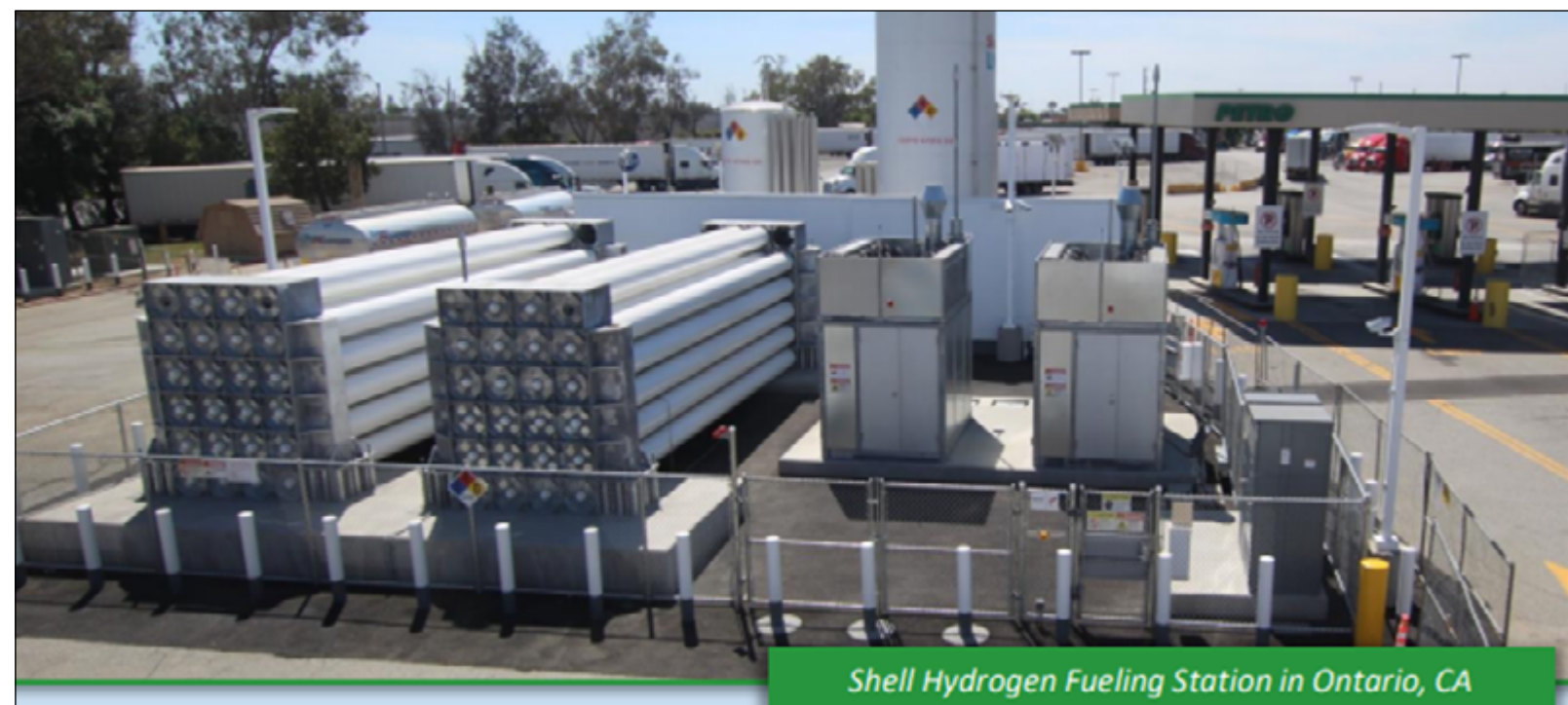
Figura 21: HRS di grande capacità per il rifornimento di autocarri a idrogeno in Ontario, CA
