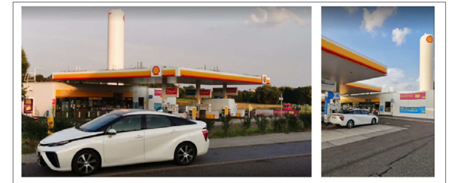
Figura 17: Panoramica stazione combinata (Germania)
